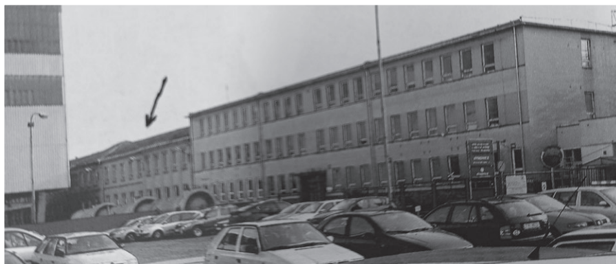
Budovy dřívější „kotlárný“, kolem nich vedla Pohraniční ulice a jezdila tramvaj č. 1. Vlevo v menší budově byly dříve v obou patrech konstrukční kanceláře, nahoře pro parní kotle, dole pro ostatní výrobky. V roce 1955 jsem zde nastoupil do prvního zaměstnání. Budova v popředí zde v roce 1955 nebyla
